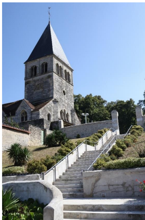
Figure 5 – L'église de Veslud
